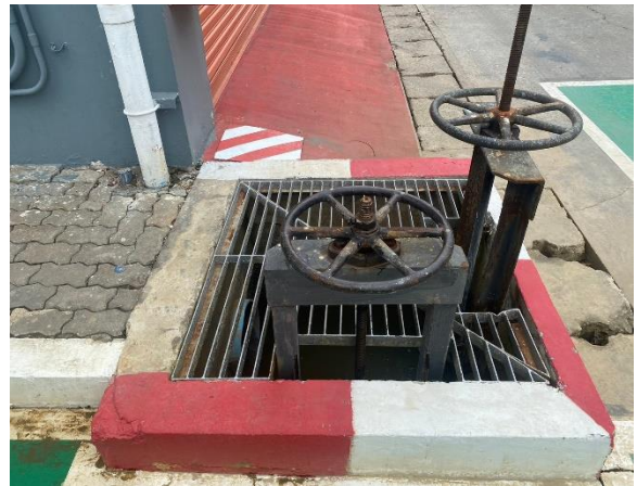
รูปที่ 2.1-17 รูปท่อรวบรวมน้ำฝนปนเปื้อน ก่อนเข้าระบบบำบัดน้ำเสีย
