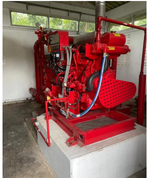
รูปที่ 2.1-36 ระบบเครื่องสูบน้ำดับเพลิง ระบบ Vertical pump
