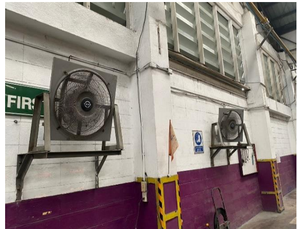
รูปที่ 2.1-26 พัดลมระบายอากาศในอาคารผลิต
