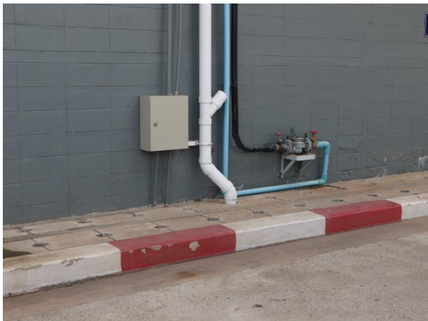
รูปที่ 2.1-18 รูปท่อรวบรวมน้ำฝนไม่ปนเปื้อน
