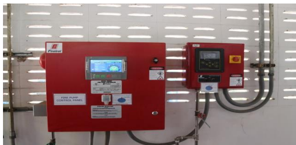
รูปที่ 2.1-35 ระบบดับเพลิงแบบสายสูบล
