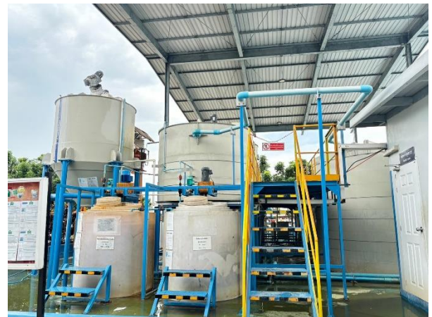
รูปที่ 2.1-11 ระบบบำบัดน้ำเสียทางเคมีของโครงการ
